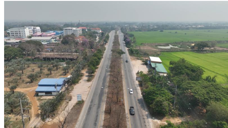
รูปการสำรวจสภาพพื้นที่แนวสายทาง ทล.1 ช่วง กม.2+000 โดย Drone
