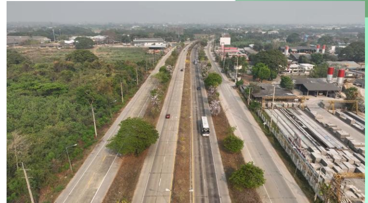
รูปการสำรวจสภาพพื้นที่แนวสายทาง ทล.11 ช่วง กม.0+250 โดย Drone 22
