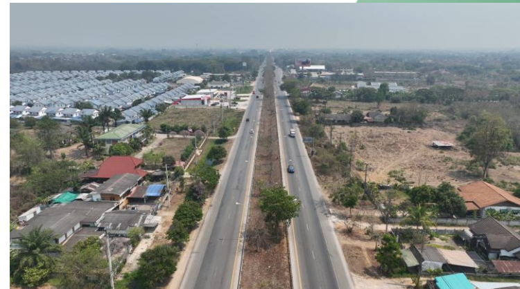
รูปการสำรวจสภาพพื้นที่แนวสายทาง ทล.1 ช่วง กม.0+250 โดย Drone
