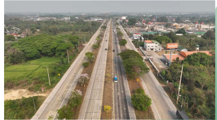
รูปการสำรวจสภาพพื้นที่แนวสายทาง ทล.11 ช่วง กม.0+000 โดย Drone
