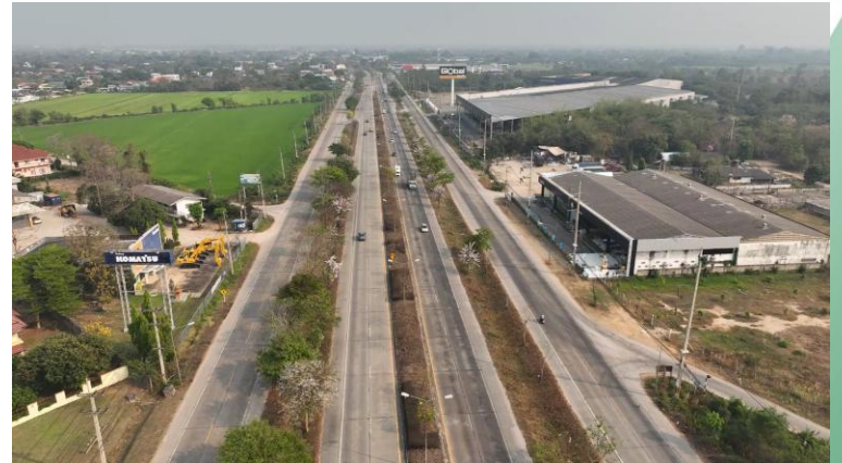
รูปการสำรวจสภาพพื้นที่แนวสายทาง ทล.11 ช่วง กม.1+500 โดย Drone
