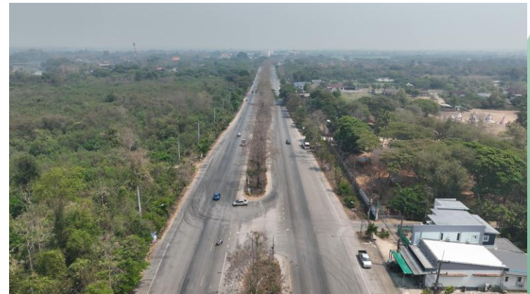
รูปการสำรวจสภาพพื้นที่แนวสายทาง ทล.1 ช่วง กม.1+000 โดย Drone
