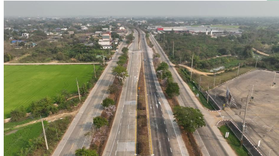
รูปการสำรวจสภาพพื้นที่แนวสายทาง ทล.11 ช่วง กม.2+000 โดย Drone
