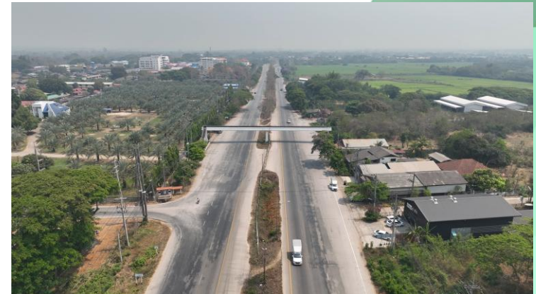
รูปการสำรวจสภาพพื้นที่แนวสายทาง ทล.1 ช่วง กม.1+750 โดย Drone
