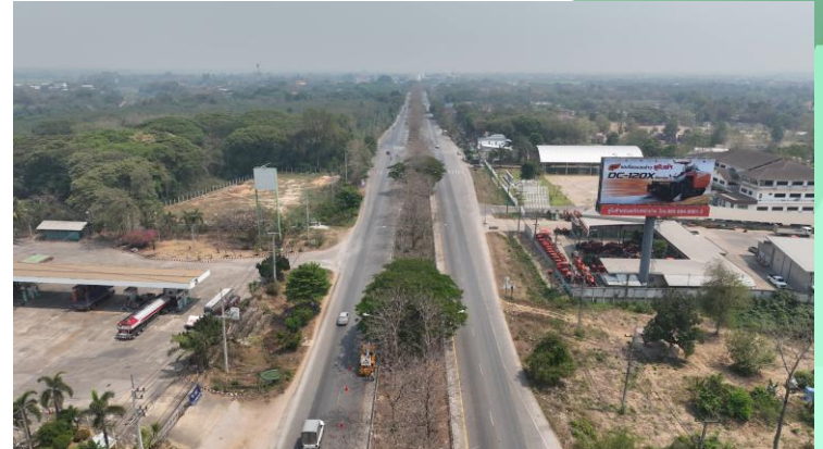
รูปการสำรวจสภาพพื้นที่แนวสายทาง ทล.1 ช่วง กม.0+750 โดย Drone
