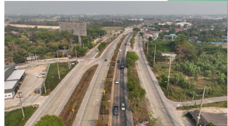
รูปการสำรวจสภาพพื้นที่แนวสายทาง ทล.11 ช่วง กม.0+750 โดย Drone
